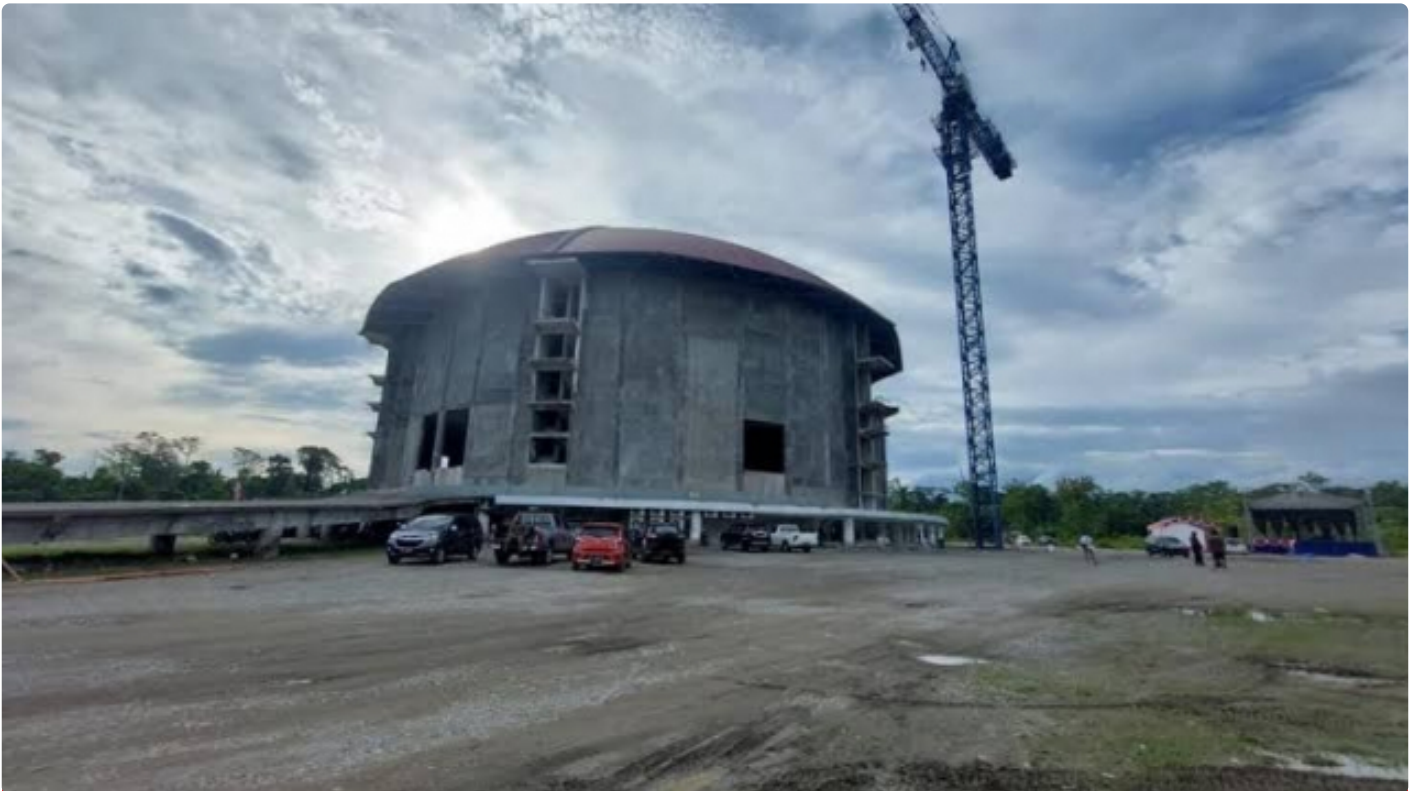
Pembangunan Gereja Kingmi Mile 32
