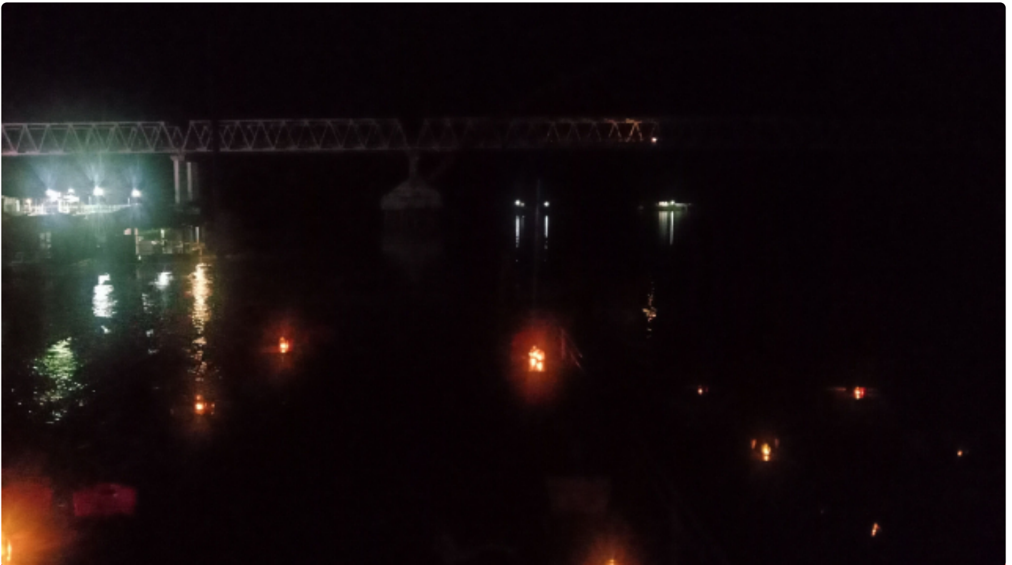
Gambar Jembatan Kahayan Dengan Kondisi Mati, gambar diambil malam tadi 30/7/22 dari kafe terapung Kota Palangka Raya
